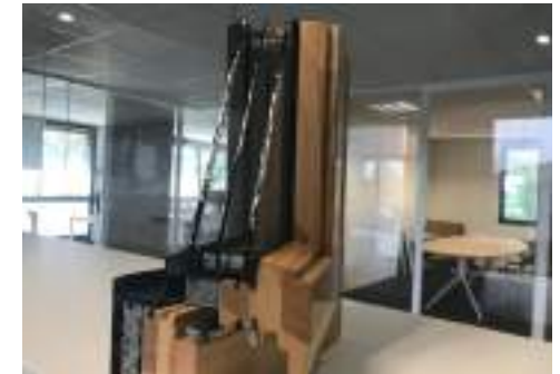
Coupe sur un triple vitrage
